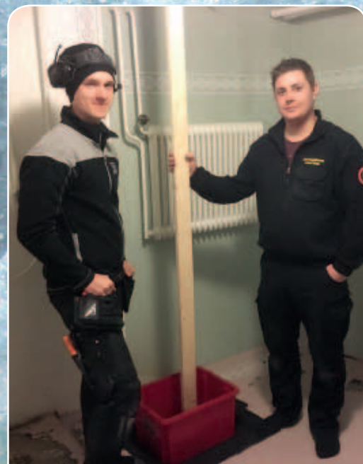
Genom att tätas golvbrunnar i källaren minskar du risken för att vatten ska tränga in. Med en gummi-matta med hink och stämp mot taket kan du få den relativt tät. "Ha alltid koll på läget", säger brandman Örjan Eriksson och beredskapssamordnare Johan Westh. Foto: Johan Brolin
