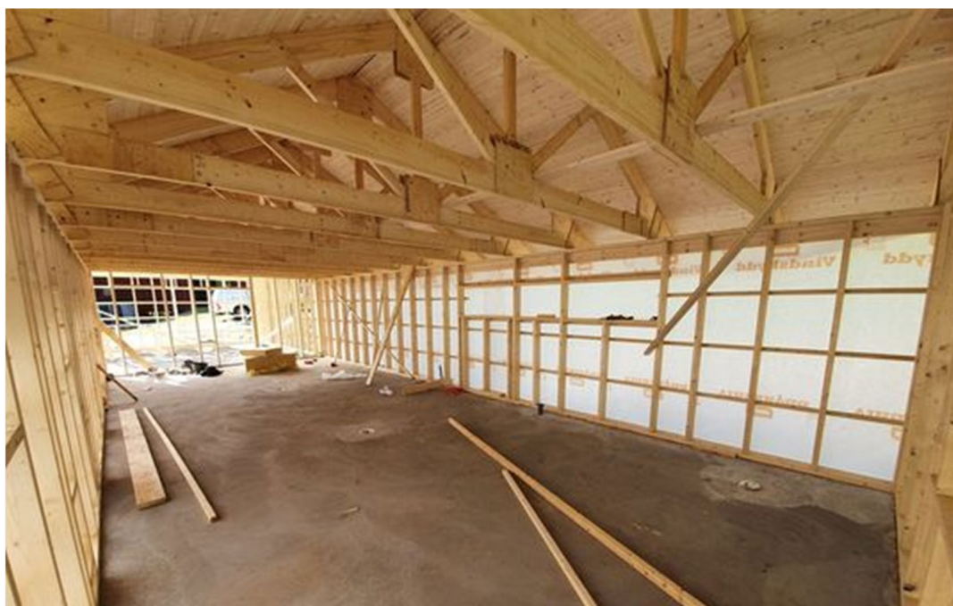
Figur 2. Pågående byggprojekt med stomme av trä.
